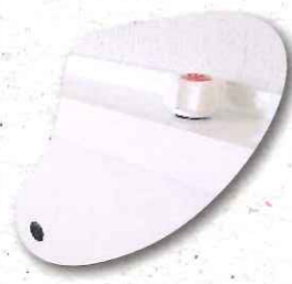
ボード脱落防止のボルト固定
